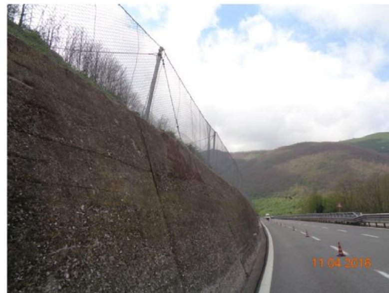
Schema barriera paramassi fissa – difesa passiva
