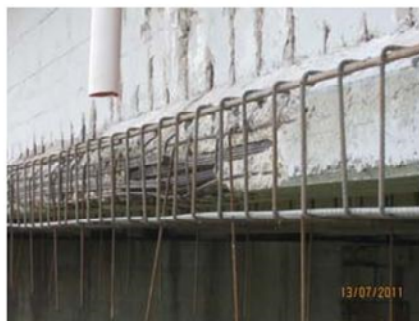
Armatura per ringrosso bulbo Casseratura per getto
