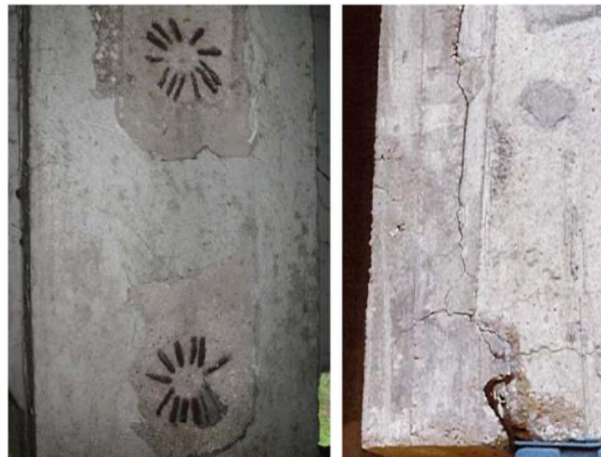
Testate non sigillate Distacco tamponi testate
