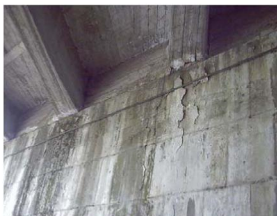
Cls in distacco con armatura scoperta
