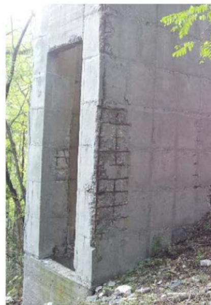
Cls in distacco con armatura scoperta
