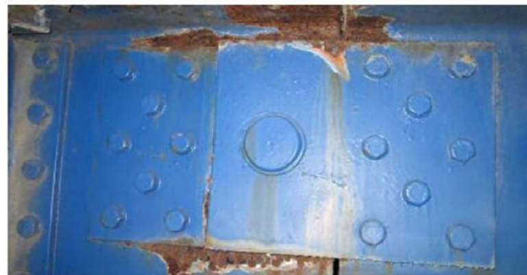
Particolare inizio corrosione
