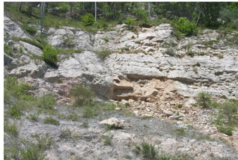
Pareti in roccia con distacco materiale lapideo
