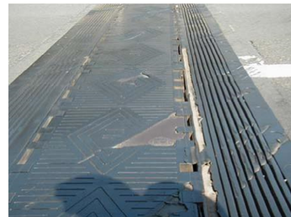
Rottura totale del giunto acciaio - gomma
