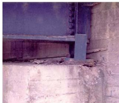
Deformazione piastre Ovalizzazione rullo Bulloni tranciati Deterioramento teflon
