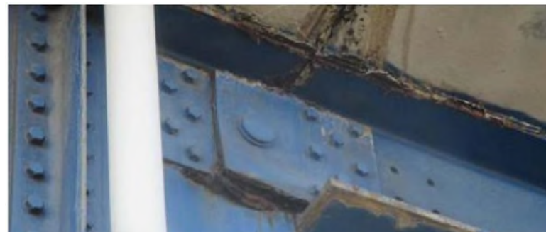
Inizio corrosione cerniera
