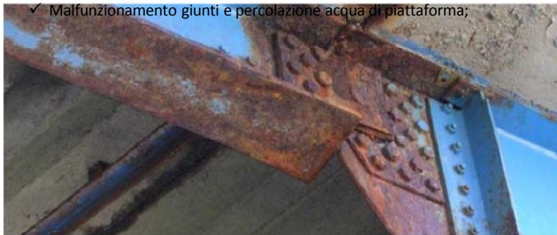
Corrosione cerniera
