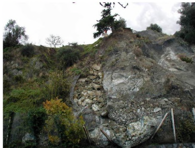
Pareti in roccia con distacco materiale lapideo
