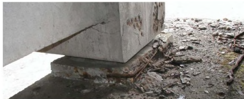
Ammaloramento calcestruzzi
