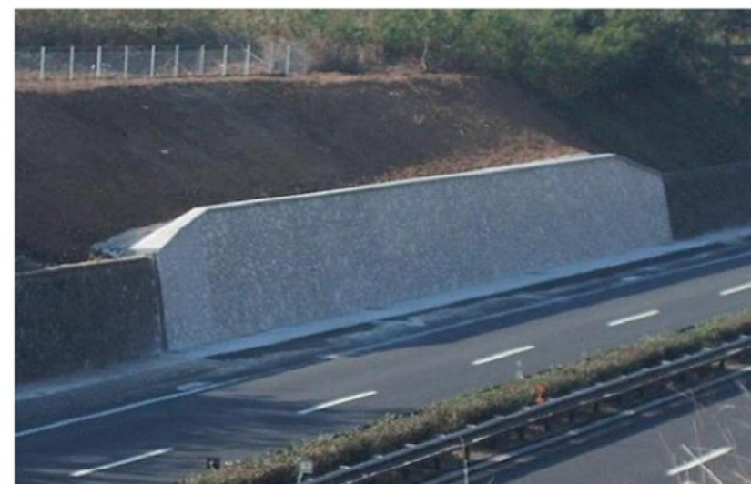
A1 km 581 Sud – crollo muro in pietrame esistente e ricostruzione muro in c.a.
