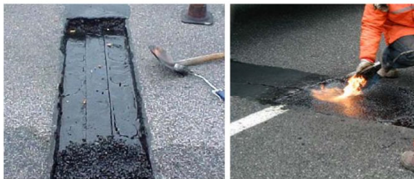
Ripristino giunto a tampone viscoelastico
