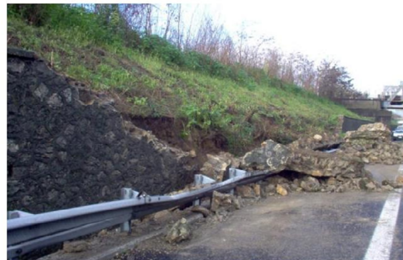
A1 km 581 Sud – crollo muro in pietrame esistente e ricostruzione muro in c.a.
