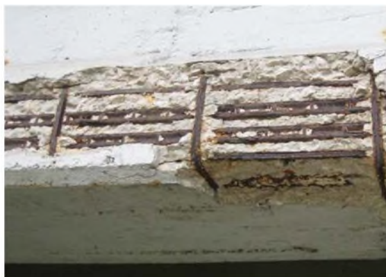
Armatura scoperta e ossidata Armatura scoperta con voto 40 Riduzione di sezione armatura
