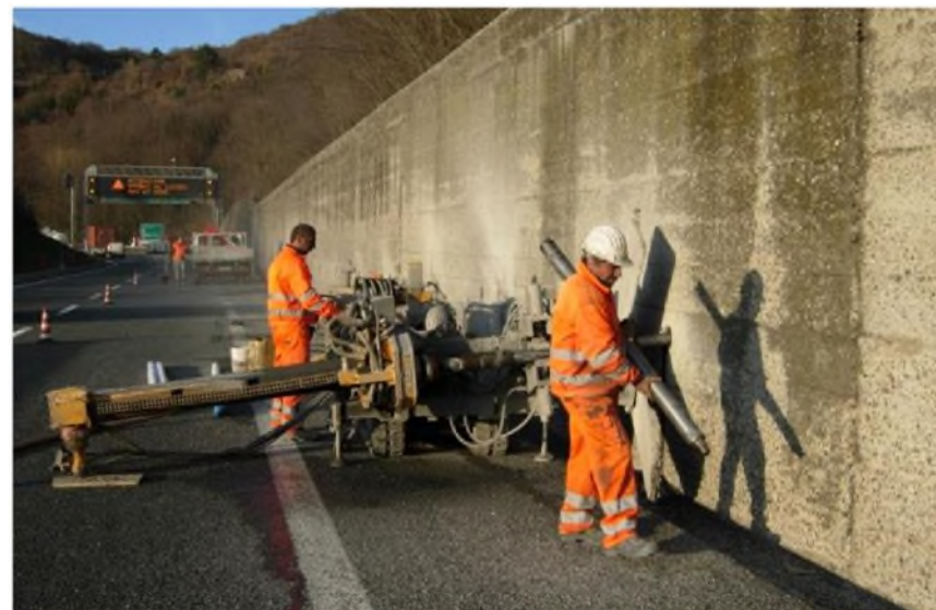
Realizzazione dreni microfessurati su muro esistente
