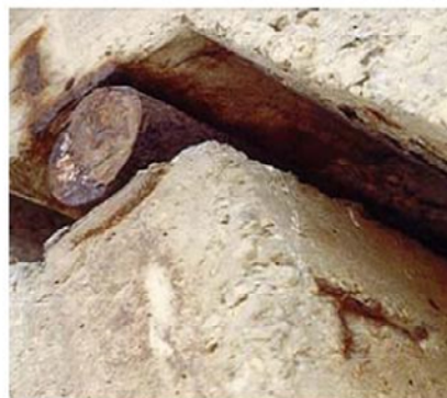
Deformazione piastre Ovalizzazione rullo Bulloni tranciati Deterioramento teflon
