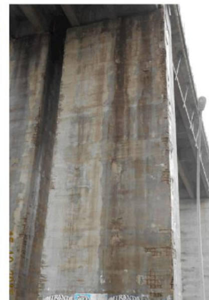
Correlazioni: Cls ammalorato e distaccato con armatura scoperta (V.tto Alento)
