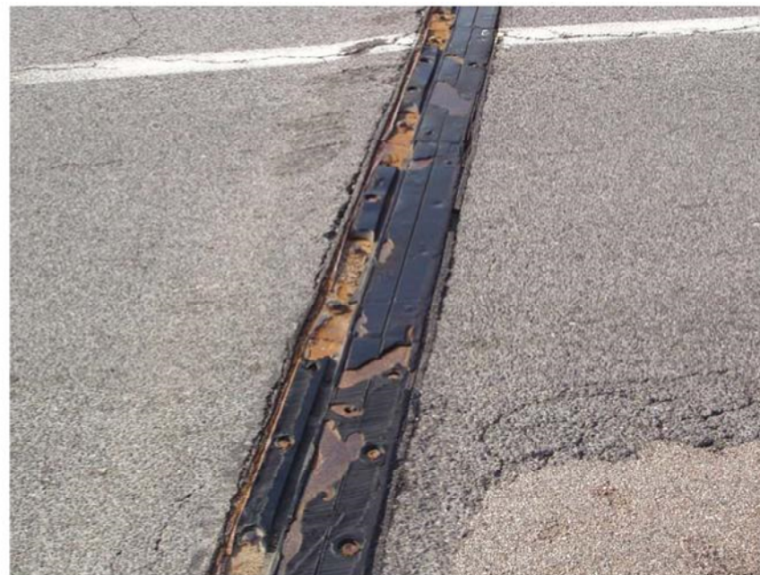
Rottura totale del giunto acciaio - gomma
