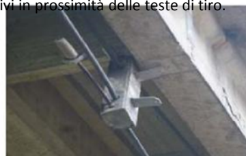
Rottura barre di precompressione Squilibrio e rottura del deviatore
