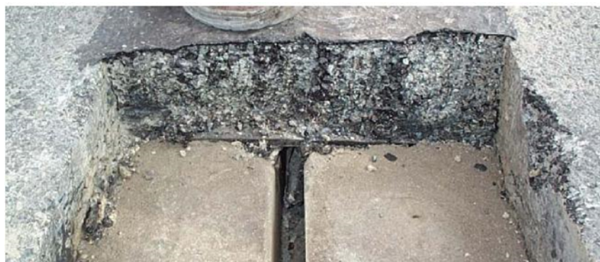
Demolizione giunto a tampone viscoelastico
