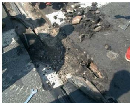
Demolizione giunto Realizzazione massetto
