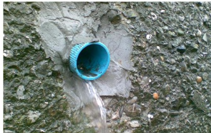
Realizzazione dreni microfessurati su muro esistente
