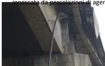
Rottura barre di precompressione Squilibrio e rottura del deviatore
